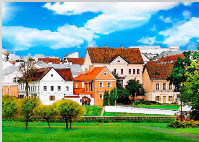
г. Минск Троицкое предместье Краска FLAGMAN 31 фасадная Краска FLAGMAN 31T фасадная для систем утепления Грунтовка FLAGMAN 08 гидроизолирующая Окрашено в 2008 г.
